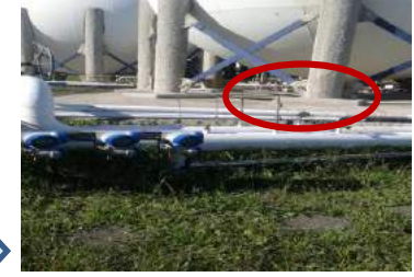
Etil Merkaptan Enjeksiyon Noktası
